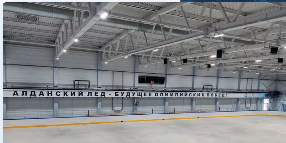
Физкультурно-оздоровительный комплекс с катком, г. Алдан (Республика Саха), Diora Unit
