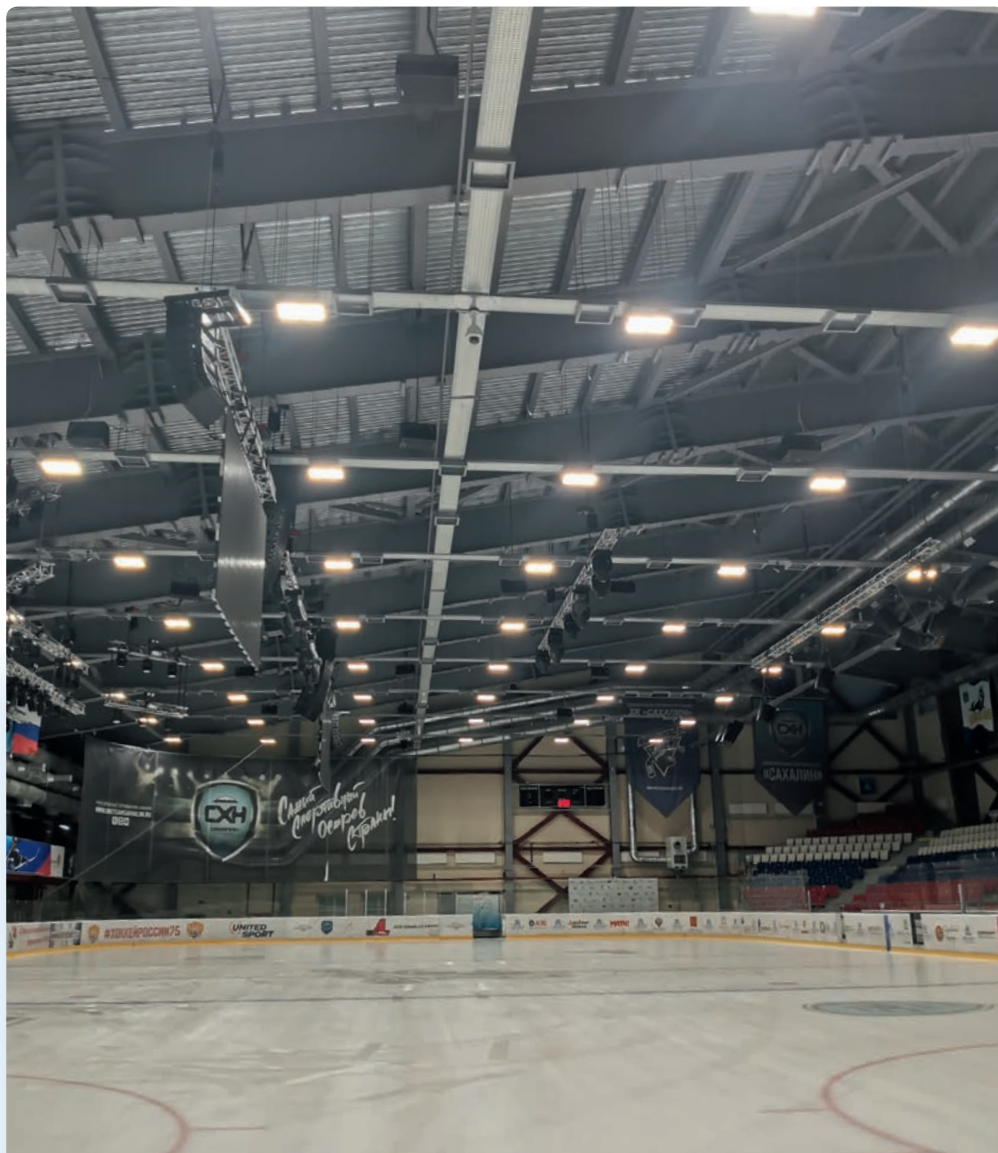
Ледовая арена ОГАУ ДО «СШ «Кристалл», г. Южно-Сахалинск, Diora Unit Д
