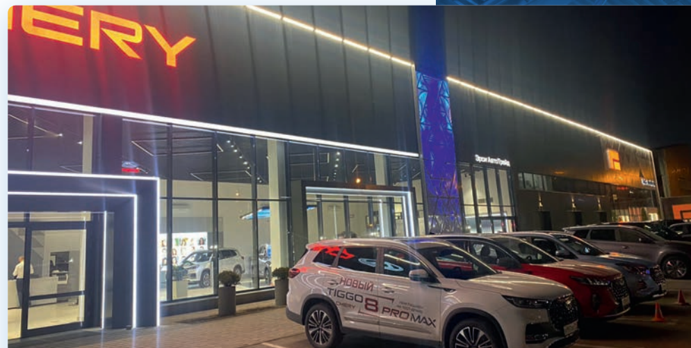
Автоцентр CHERY, г.Москва, Diora Tubus
