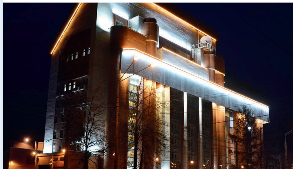
Центробанк, г.Томск, Diora Unit, Diora Tubus
